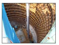
中央浅田幹線は大量の下水と雨水を集める必要があるため、浜松市の下水道の中でも最大の外径4,550mmの管を道路の下に築造しています。周辺環境や道路交通への影響を少なくするため、地面の下をトンネルのように掘って、管を送りながら進んでいく「シールド工法」という方法で工事が行われたそうです。
